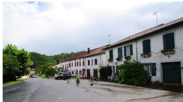
Le quartier de Pessarou et son front bâti continu
