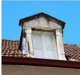
Lucarnes avec fronton et piédroits en pierre de taille
