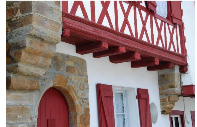
Mur de refend en pierre et encorbellement.
