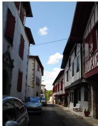
Les façades est sont à pans de bois, les façades ouest sont maçonnées
