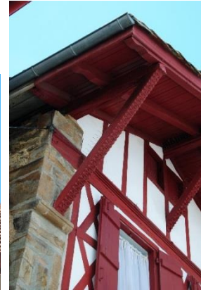
Large débord de toiture soutenu par des jambes d'appui en bois décorées
