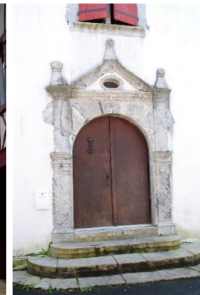
Portail d'entrée en pierre, arc en plein cintre, occulus; perron en pierre.
