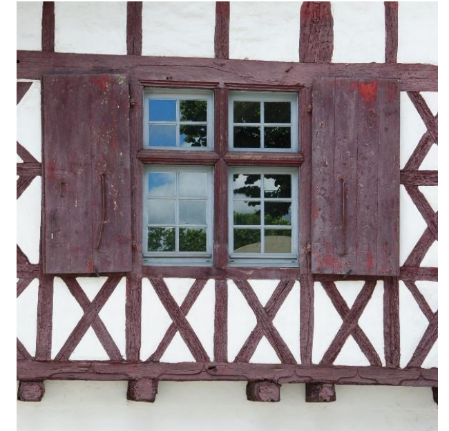
Baie à croisée en bois, volets pleins, pan de bois régulier à croix de Saint-André
