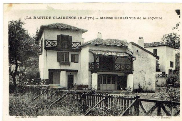
Les façades arrières, leur caractère
