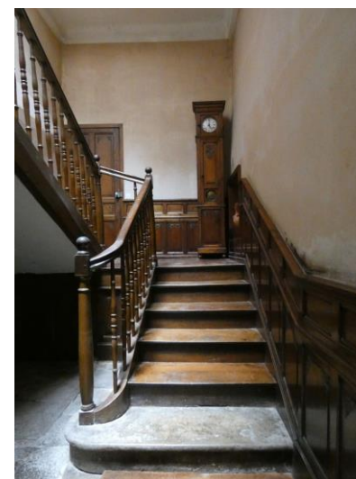
Escalier, lambris d'appuis, menuiseries de portes palières; maison « Chinon » (extrait de l'Inventaire du bâti)
